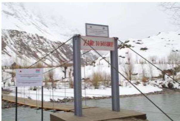
Мост, построенный в кишлаке Сижд, предоставляет безопасный доступ к соседним кишлакам и к главной дороге
