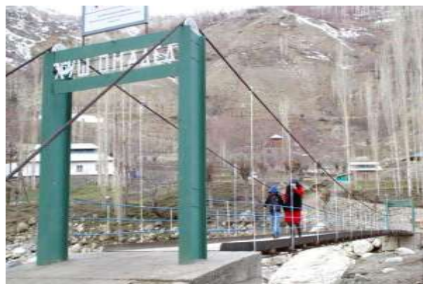
Построенный мост в селе Андарв. Также в рамках проекта были завершены берегоукрепительные работы в 3 сёлах и восстановление ирригационного канала в 1 селе
