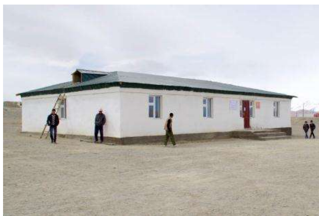
Было построено новое здание
