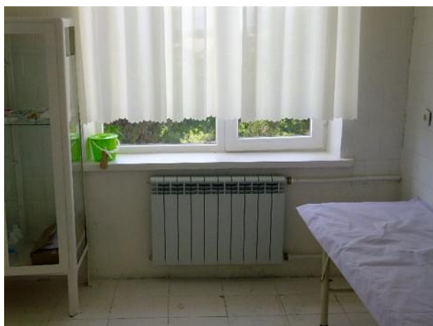
Новые радиаторы системы отопления, установлены в каждой палате отделения
