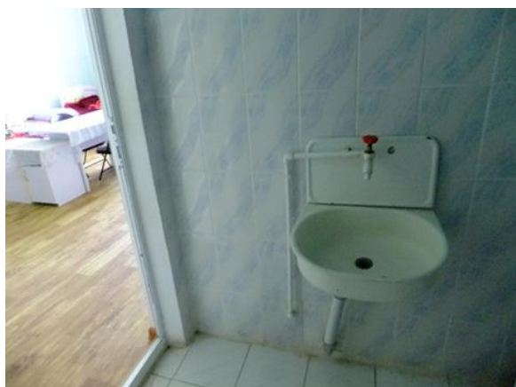
В здании больницы была восстановлена система внутреннего водоснабжения
