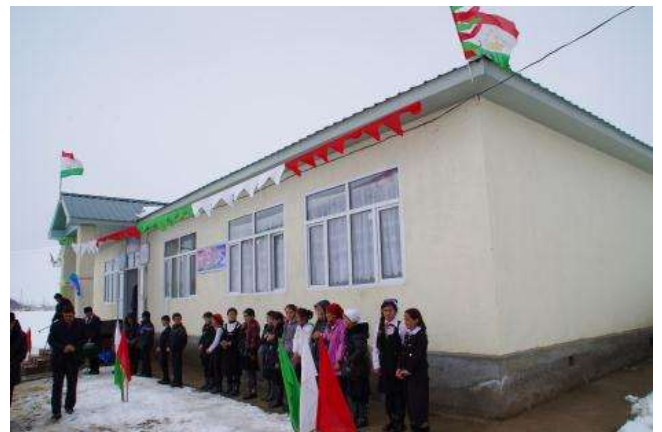
建設された第12学校新校舎の外観。
