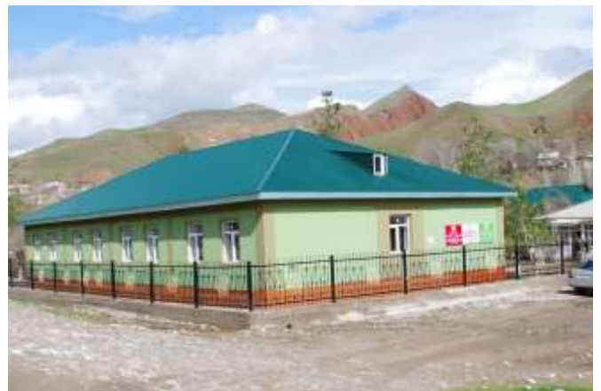
完成した第2病棟の外観。
