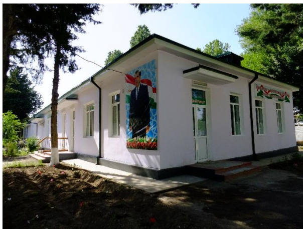
老朽化のため1996年から閉鎖されていた病棟が改修工事により甦りました。
