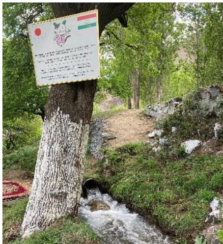
Установленная ирригационная система
