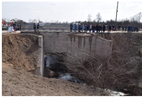
ヤッカディン地区ヤッカディン村の改修前の橋および改修後の橋。
