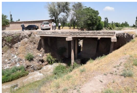
ヤッカディン地区キロブ村の改修前の橋および改修後の橋。
