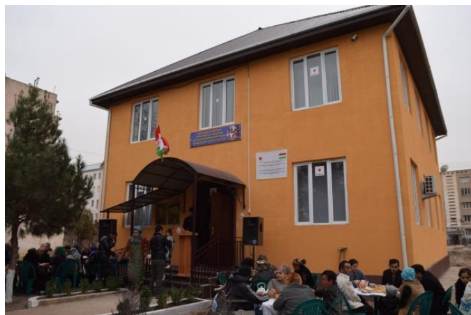
女性センターの外観。入り口には、我が方の支援を示す日章旗プレートが添付されていました。
