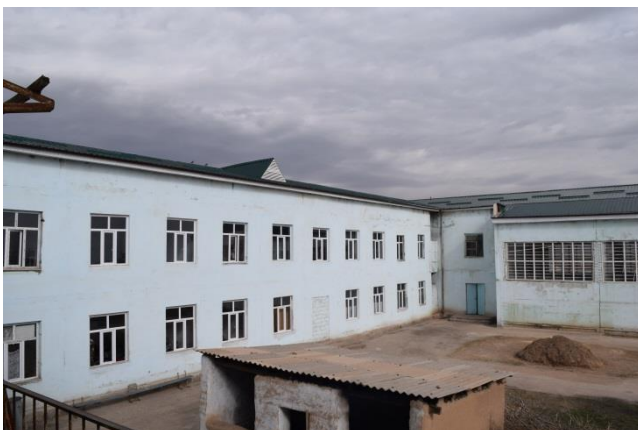
今般、草の根の支援により設置された屋根。
