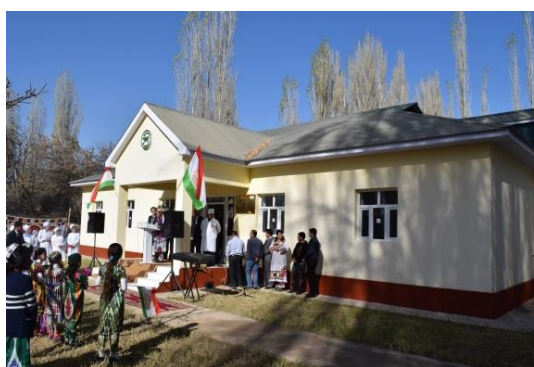
Вид отремонтированной больницы.
