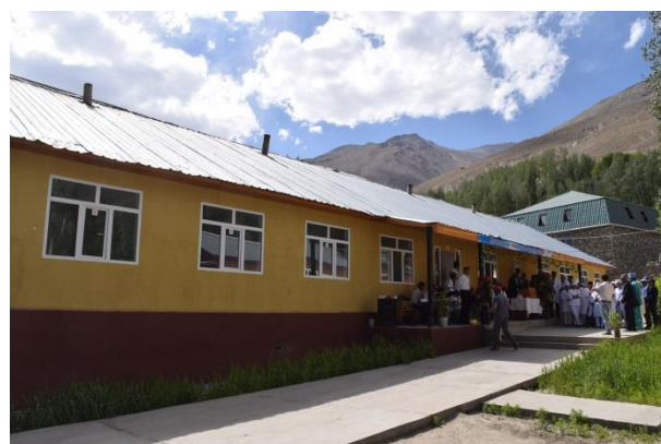
改修された病棟の外観。
