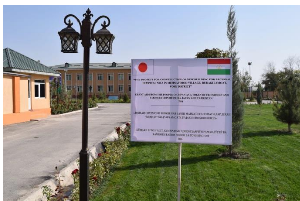
Вывеска проекта с указанием поддержки Японии, установленная у здания больницы
