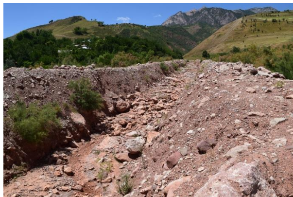
Водоотводный канал, построенный в рамках проекта. При помощи этого канала снизилось воздействие сезонных наводнений
