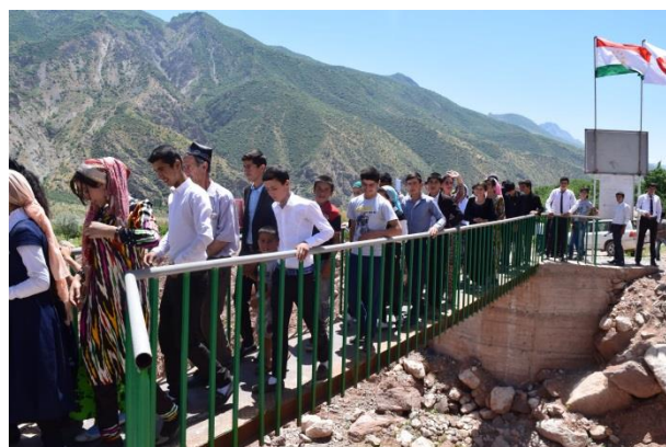
Пешеходный мост, построенный в рамках проекта. Он облегчил передвижение по деревне даже в дождливый сезон
