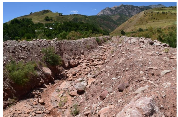
本計画を通じ建設された水路。この水路により洪水被害が低減されました。
