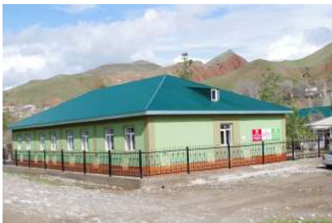
Новое дополнительное здание, построенное в рамках настоящего проекта для центральной районной больницы
