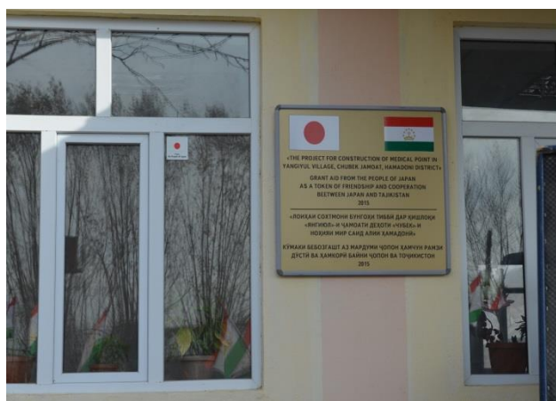
Баннер у входа медпункта свидетельствует об успешном завершении проекта по безвозмездной помощи Республики Таджикистан правительством Японии.
